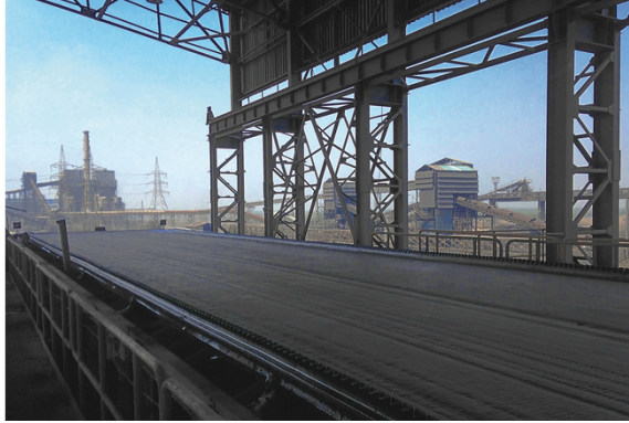
Filtro de banda al vacío en operación
